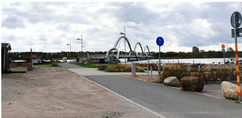
Foto som visar cykelvägen i den södra delen av planområdet, sett mot bron.
