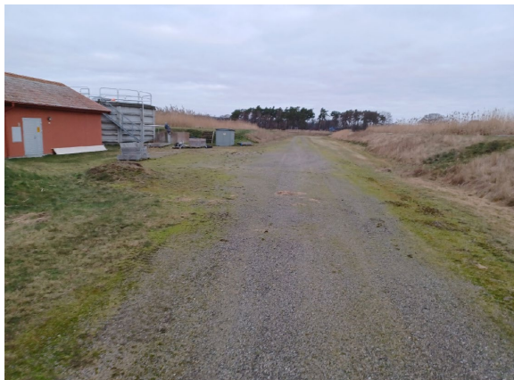
Bilden visar den tekniska anläggningen för vassbäddarna. Bildkälla: Rejlers AB.
