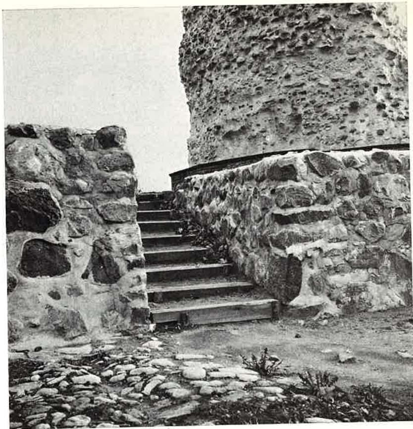
Fig. 4. Del av det restaurerade porthuset med trappan upp till borggården dragen genom den gamla trapphalsen. Från norr. Foto förf.
